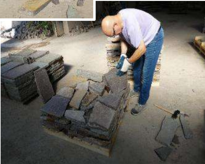
Controllo lastre con smontaggio e rimontaggio bancale (es. presenza lasso)
